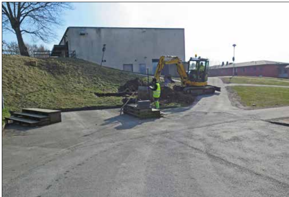
Figur 23. Schaktning och inmätning i norra delen av utredningsområde B (schakt 6). Karolina Kegel i bild. Foto mot söder.
