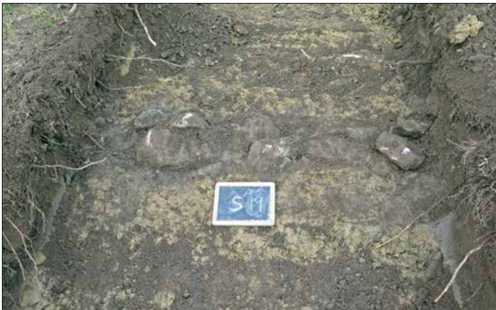
Figur 13. Dräneringsrännan A5 i schakt 19.
